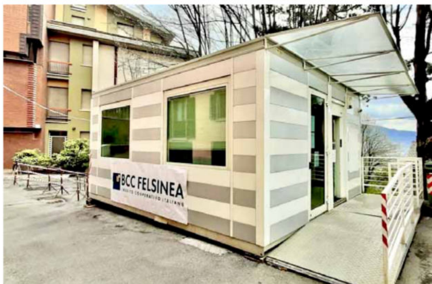
La filiale mobile installata in centro in attesa dei lavori nella sede di via Vittorio Emanuele
